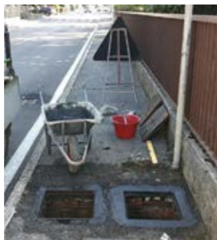
Ripristino dei POZZETTI ammalorati lungo la Via Ungaretti
