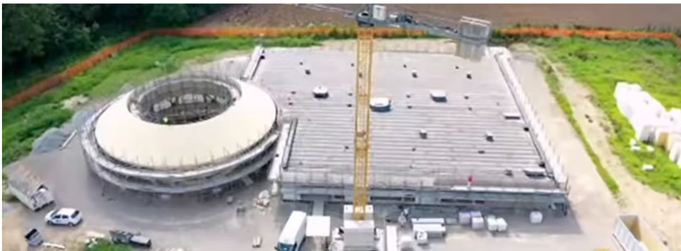
Cantiere del nuovo Polo dell'Infanzia
