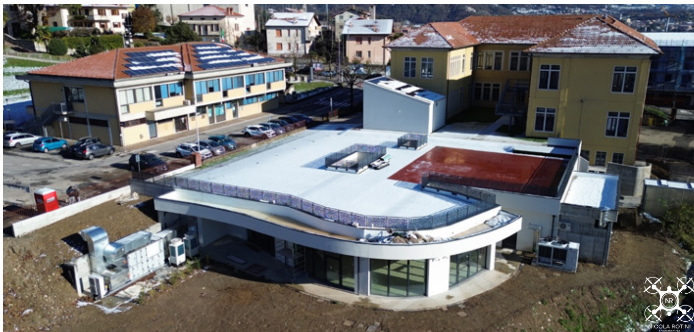
Ripresa aerea del cantiere dell'ampliamento della scuola elementare
