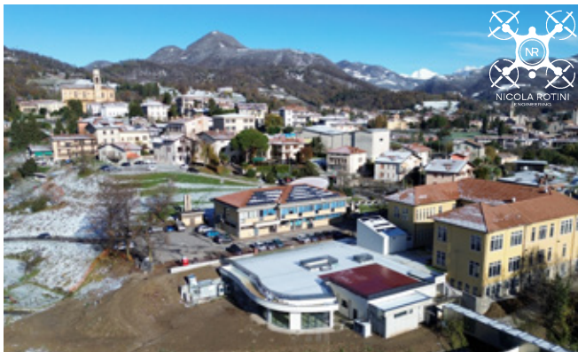
Cantiere dei lavori di ampliamento della Scuola Elementare
