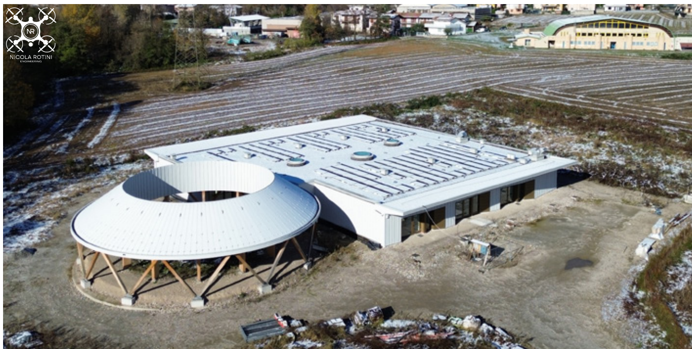
Ripresa aerea del cantiere del Polo per l'Infanzia
